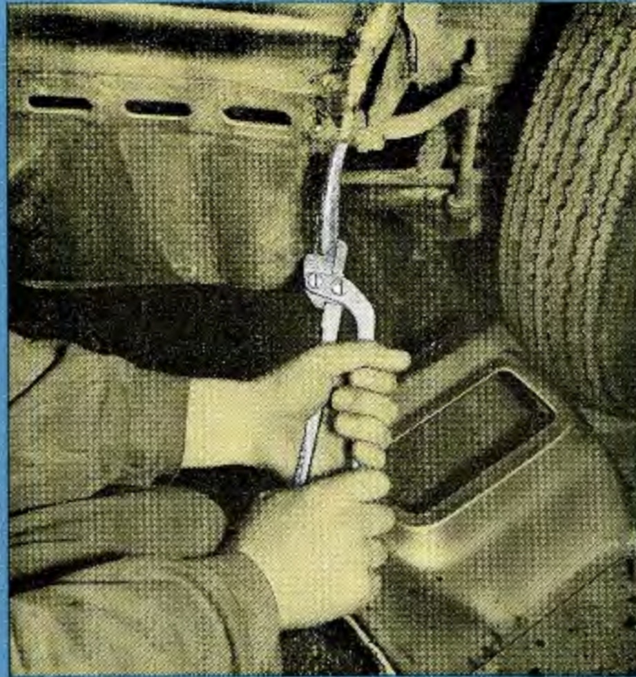
HAZET 1932 zum Absetzen von Blechkanten
